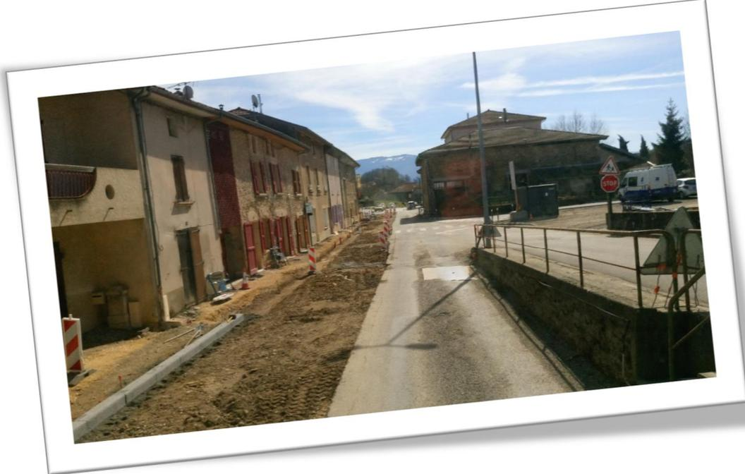
*Les travaux de l'entrée nord se sont terminés fin Mai 2018 et ont permis l'enfouissement des réseaux secs, le renforcement de la chaussée et la mise en sécurité des piétons grâce à la réalisation de trottoirs aux normes PMR.*
