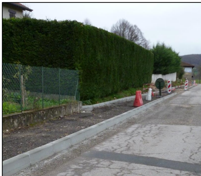
Réalisation trottoirs à l'entrée sud du village
